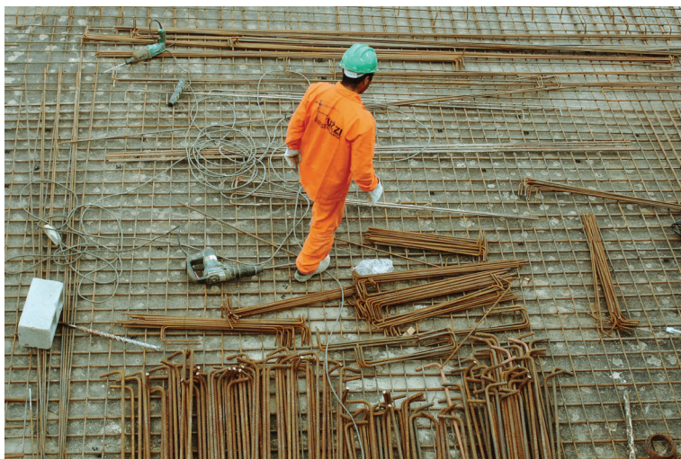
Delo na gradbišču
