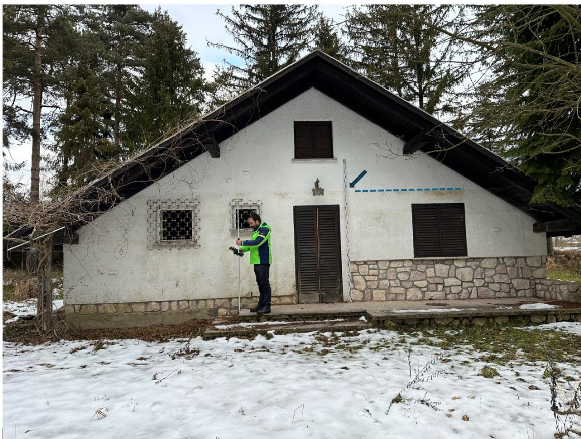
Slika 1: Globina poplavne vode nad teraso je bila med poplavo 2,35 m.
