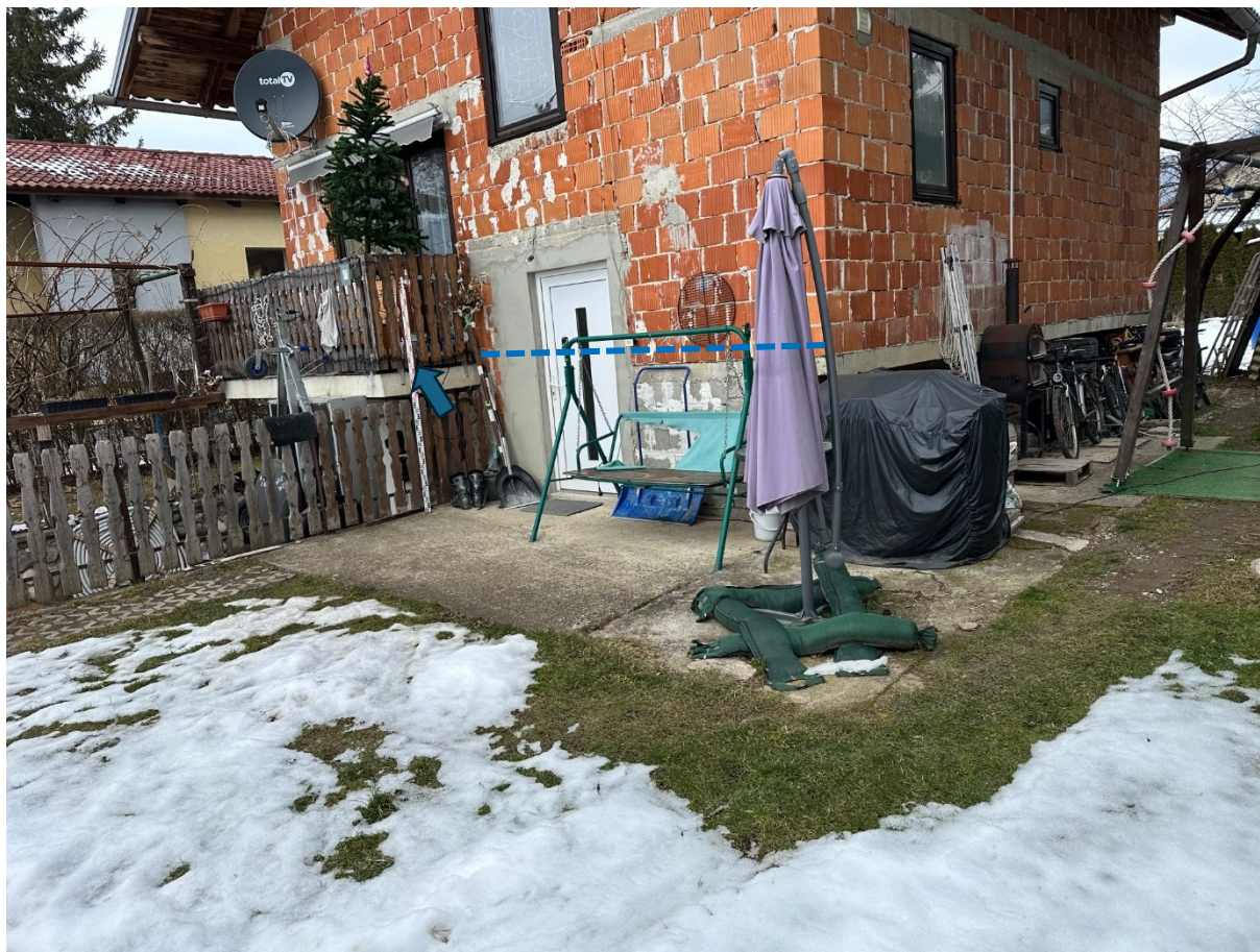
Slika 1: Poplava je segla do iznad betonske plošče. Poplavljena je bila klet in notranjost objekta. Globina vod je bila 1,3 m nad osnovnim terenom.
