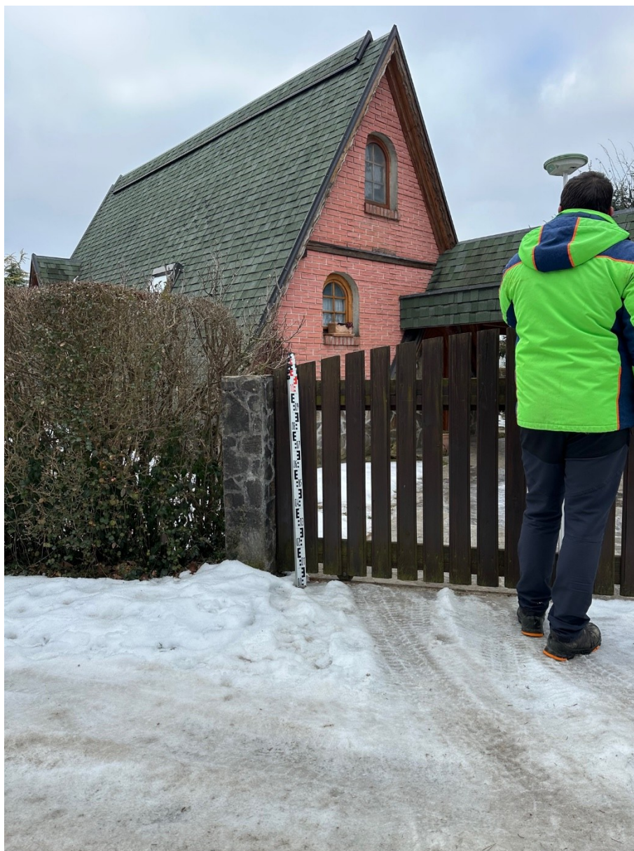
Slika 1: Gladina poplavne vode je segala 0,6m nad okoliškim terenom. Objekt ima visoko pritličje. Klet ni bila vidna.
