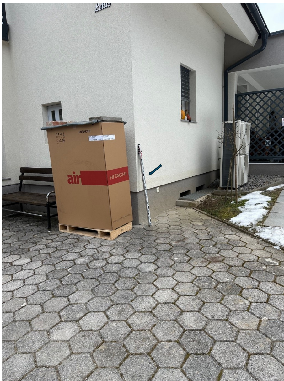
Slika 1: Gladina poplavne vode je segala do ~0,7 m nad dostopno ploščadjo. Celoten objekt je podkleten (globina vode v kleti 2,5 m). V kleti so nameščeni notranji deli toplotne črpalke.
