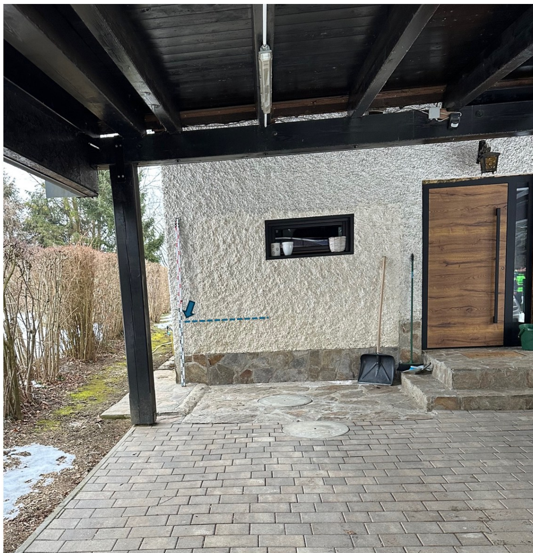
Slika 1: Sledi VV avgust 2023 na zaledni objekta glede na tok Savinje Globine vode ~ 0,8 m glede na osnovni teren ob objektu. Objekt se nahaja na nasutem robu ob Savinji. Osnovni teren je več kot 1 m nižji. Brežine Savinje so slabo utrjene z vidnimi znaki površinske erozije.
