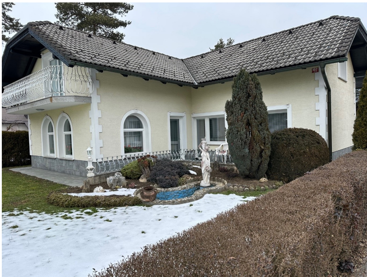
Slika 1: Gladina poplavne vode je segala 0,68 m nad koto pritličja.
