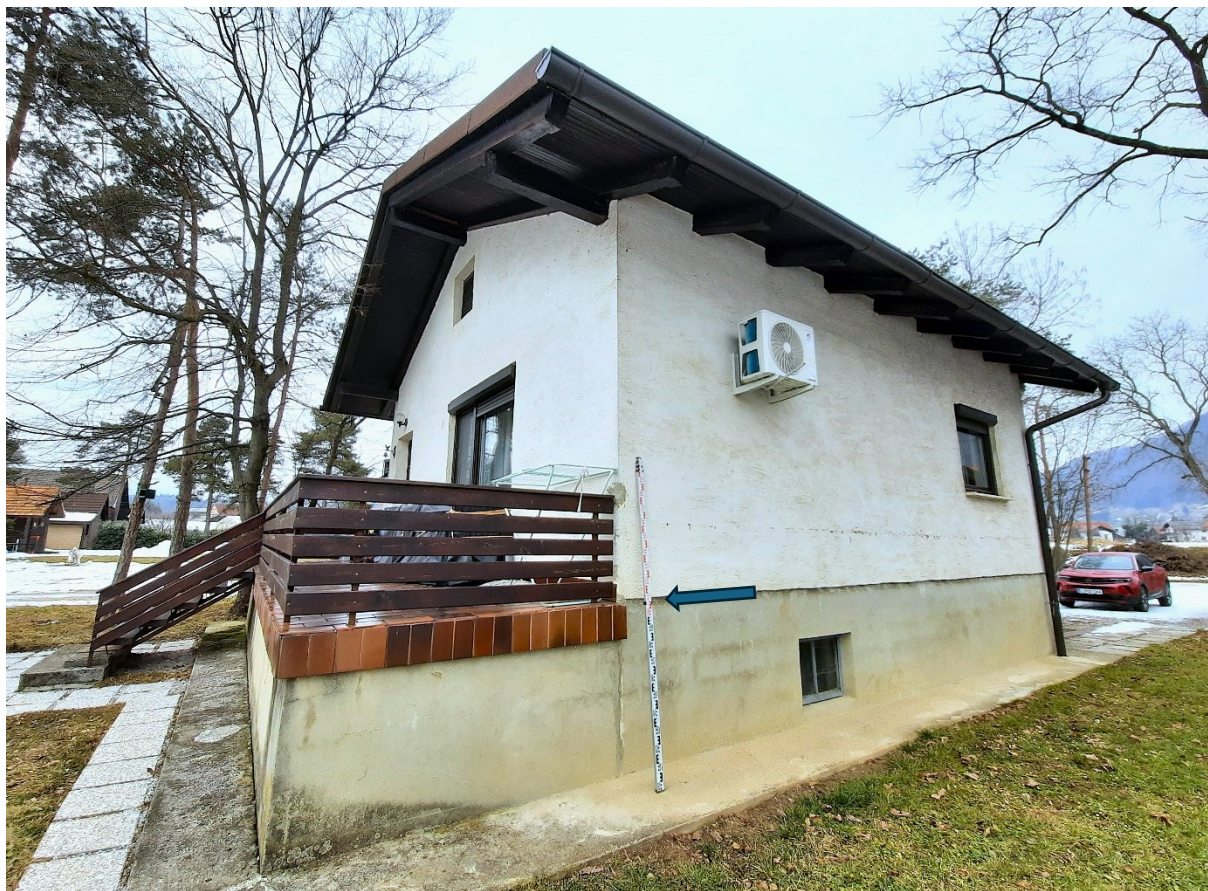
Slika 1: Globina poplavne vode pri objektu Rečica ob Savinji 51c je bila ~1,15 m.
