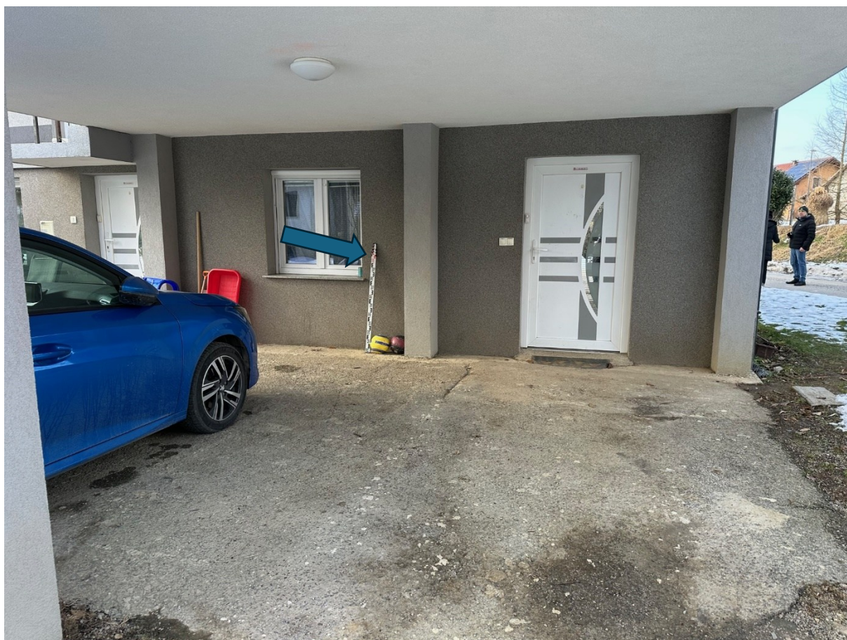
Slika 1: Južni del – vstopna stran; globina vode ~1,0 m.
