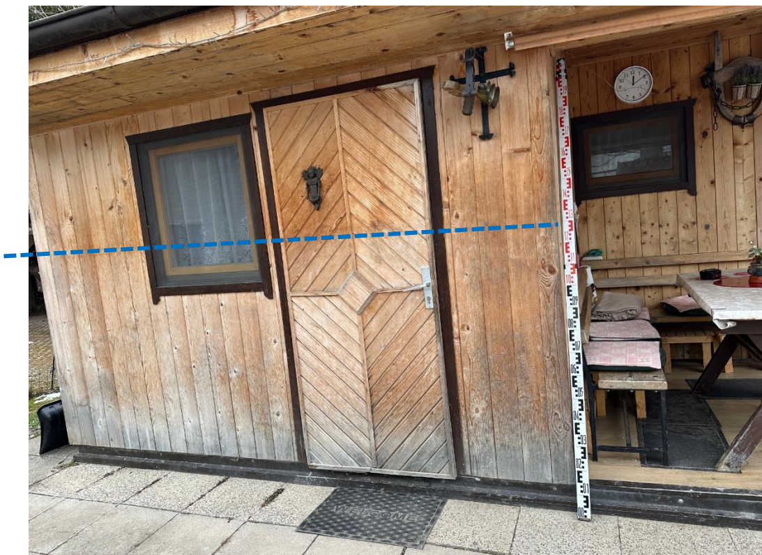
Slika 1: Južni del fasade – vstopna stran; globina vode ~1,34m.
