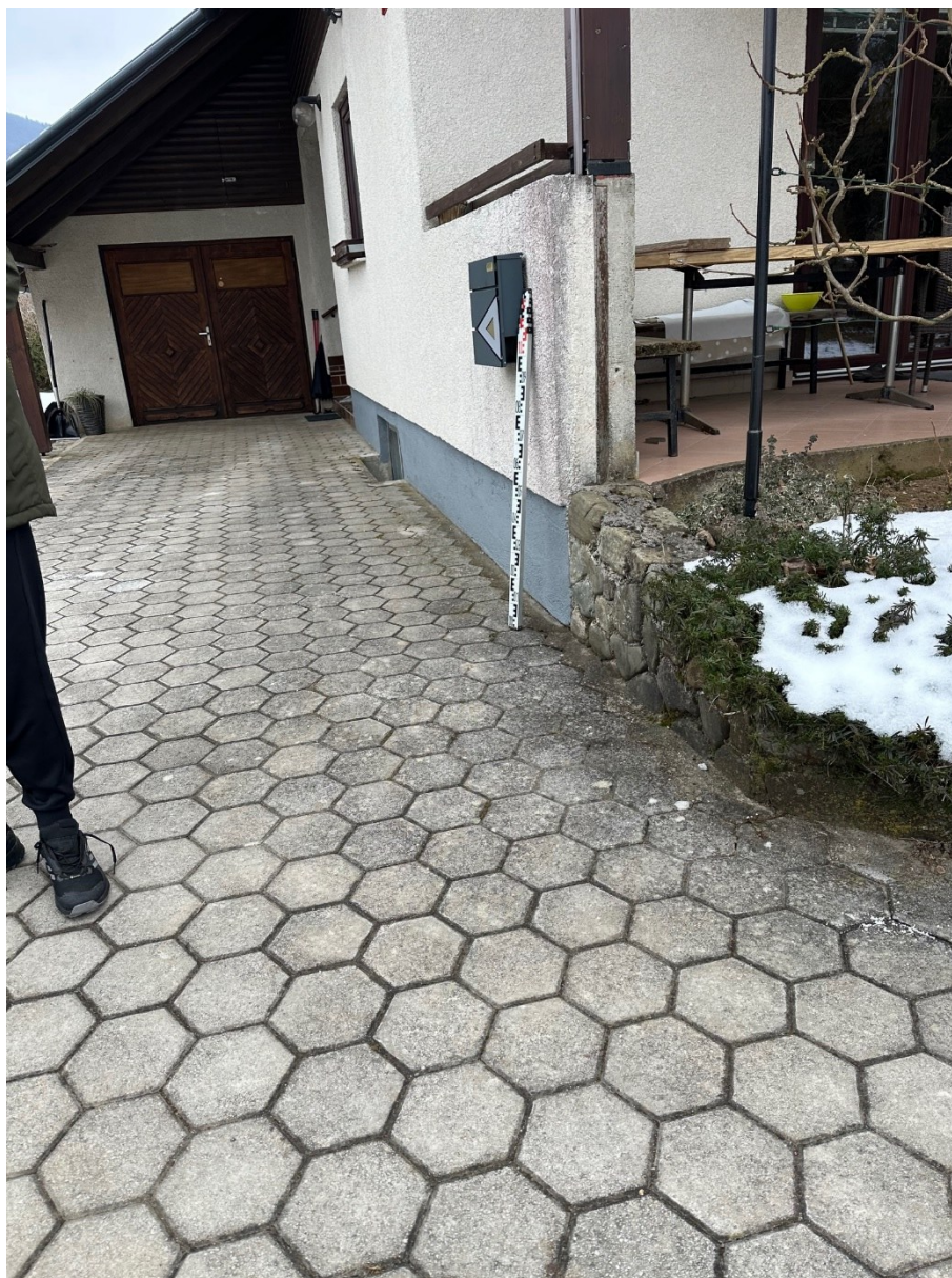
Slika 1: Gladina poplavne vode je segala do 0,1 m nad dostopno ploščadjo. Celoten objekt je podkleten (globina vode v kleti 2,5 m)
