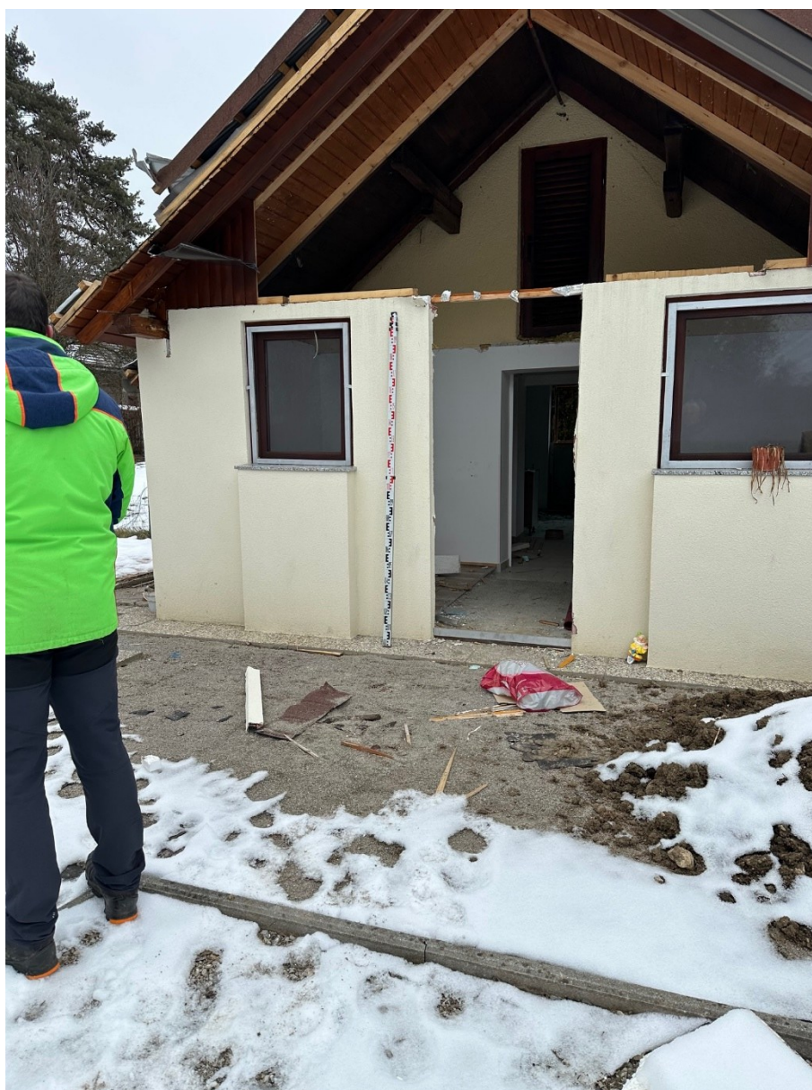
Slika 1: Gladina poplavne vode je segala 1,3 m nad koto terena. Montažni objekt je v fazi rušenja.
