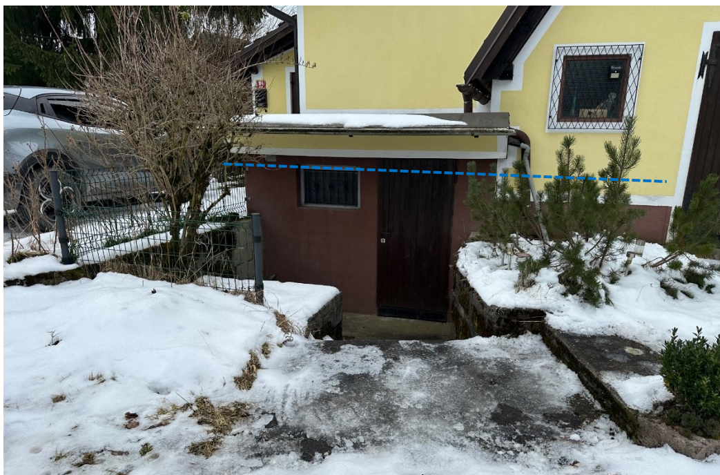
Slika 1: Poplava je segla 0,70m terenom v bivalnem delu. Objekt je delno podkleten.
