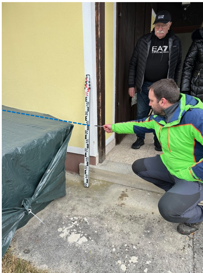
Slika 1: Poplava je segla 0,70m terenom v bivalnem delu. Objekt je delno podkleten.
