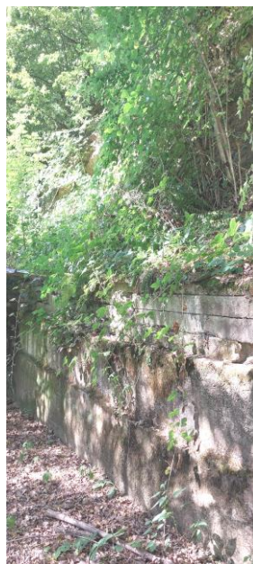
Fotografija 2: Pogled na erodirano dovozno cesto (desno), vkopna brežina izven objekta je varovana z oporno konstrukcijo (levo) (3.7.2025).
