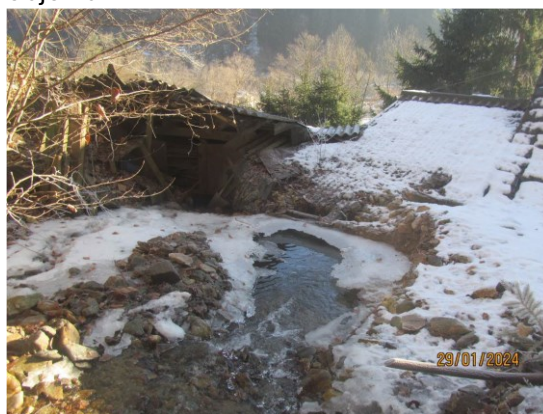
Slika 4: Pogled na del terena za stavbo - hudournik!
