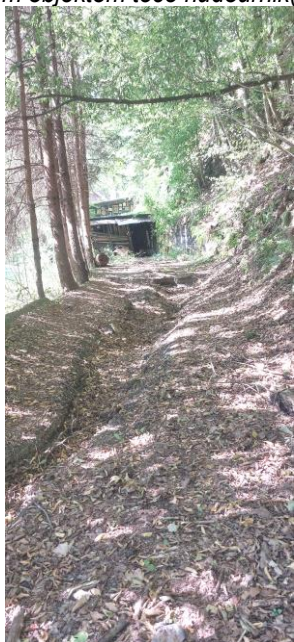
Fotografija 2: Pogled na erodirano dovozno cesto (desno), vkopna brežina izven objekta je varovana z oporno konstrukcijo (levo) (3.7.2025).
