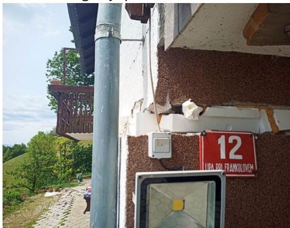
Slika 6: Fotografija vertikalnega in horizontalnega zamika stene
