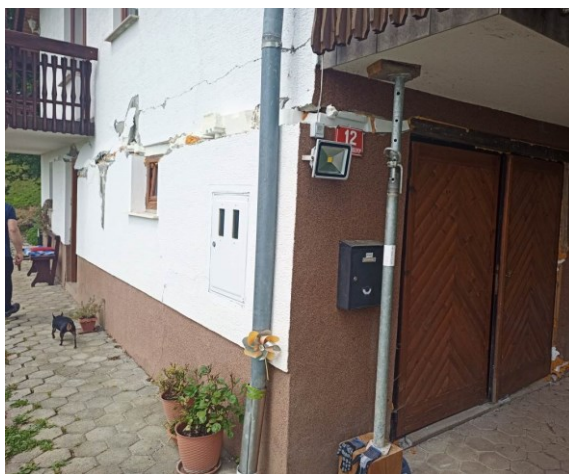
Slika 2: Fotografija objekta – JV vogal
