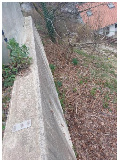
Fotografija 2: Pogled na nepoškodovan AB zid pod stanovanjskim objektom (27.2.2024).
