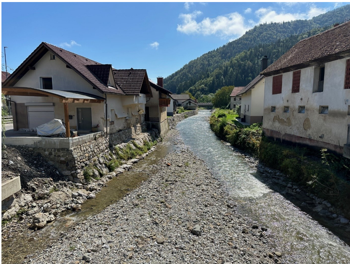
Slika objekta poleti 2024. Objekt s poškodbami se nahaja na levem bregu Drete. Garažna in vhodna vrata so zamenjana. Sledi gladine v strugi so vidne na objektu na desni strani struge.
