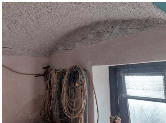
Slika 4: Horizontalne razpoke na stiku zidov in stropne konstrukcije nad kletjo
