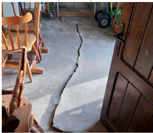
Slika 6: Razpokan in dvignjen tlak v kletni etaži
