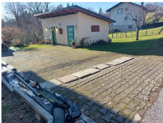
Fotografija 8: Pogled na posedeno dvorišče stanovanjskega objekta Vinarje 137 (4.1.2024).
