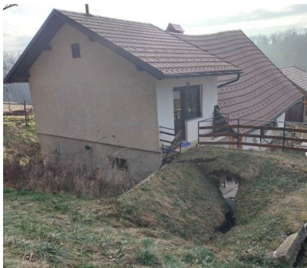
Slika 3: Severna fasada - porušena plošča prostora za shranjevanje orodja
