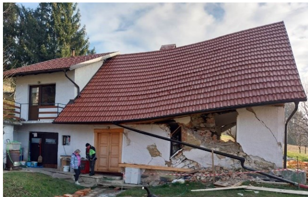
Slika 1: zahodna fasada-porušen kamniti zid, deloma tudi stropna konstrukcija ter deformirano ostrešje
