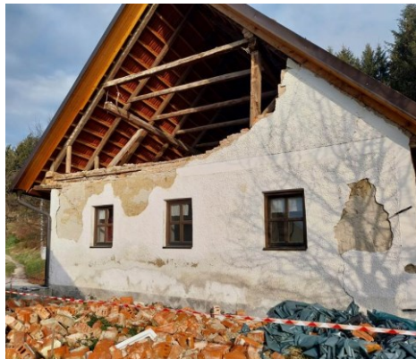
Slika 2: južna fasada-izpadel zatrepni zid
