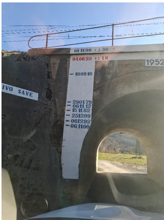
Slika 19: Prikaz oznak gladin poplavnih dogodkov pred železniškim podhodu dostopne poti do objekta Sava 4, Litija. (foto: Gosar, 5.3.2025)
