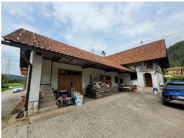
Slika 1: Pogled na objekt, JV fasada
