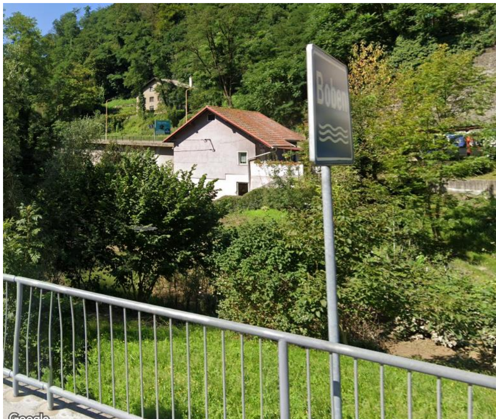
Slika 20: Prikaz obravnavanega objekta Cesta 1. maja 4, Hrastnik. (vir: Google Street View)
