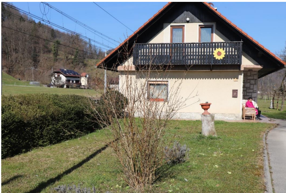
Slika 1: Prikaz obravnavanega objekta Ponoviče 10, Litija (foto: Gosar, 5.3.2025).
