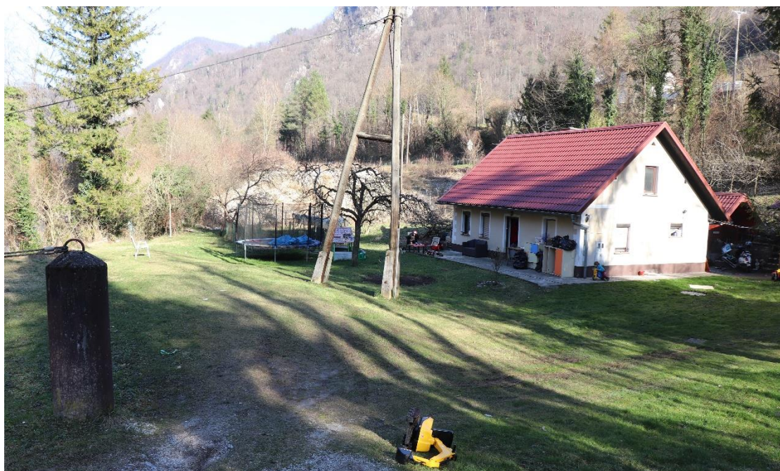
Slika 4: Prikaz obravnavanega objekta Renke 7, Litija (foto: Gosar, 5.3.2025).
