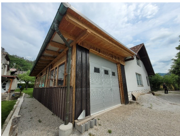
Slika 2: Pogled na objekt -južna fasada
