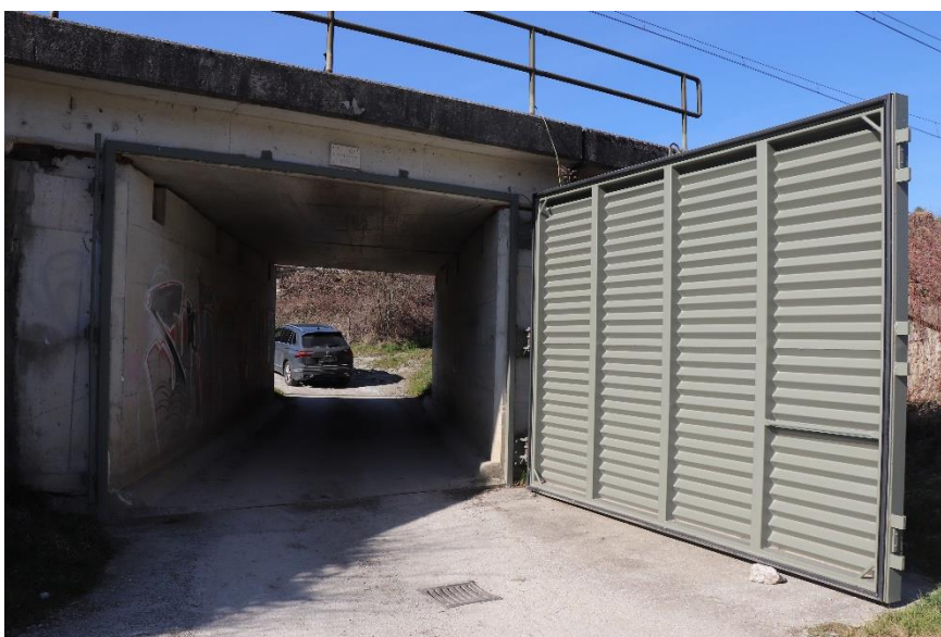
Slika 2: Prikaz ene od zapor železniškega podhoda (foto: Gosar, 5.3.2025).
