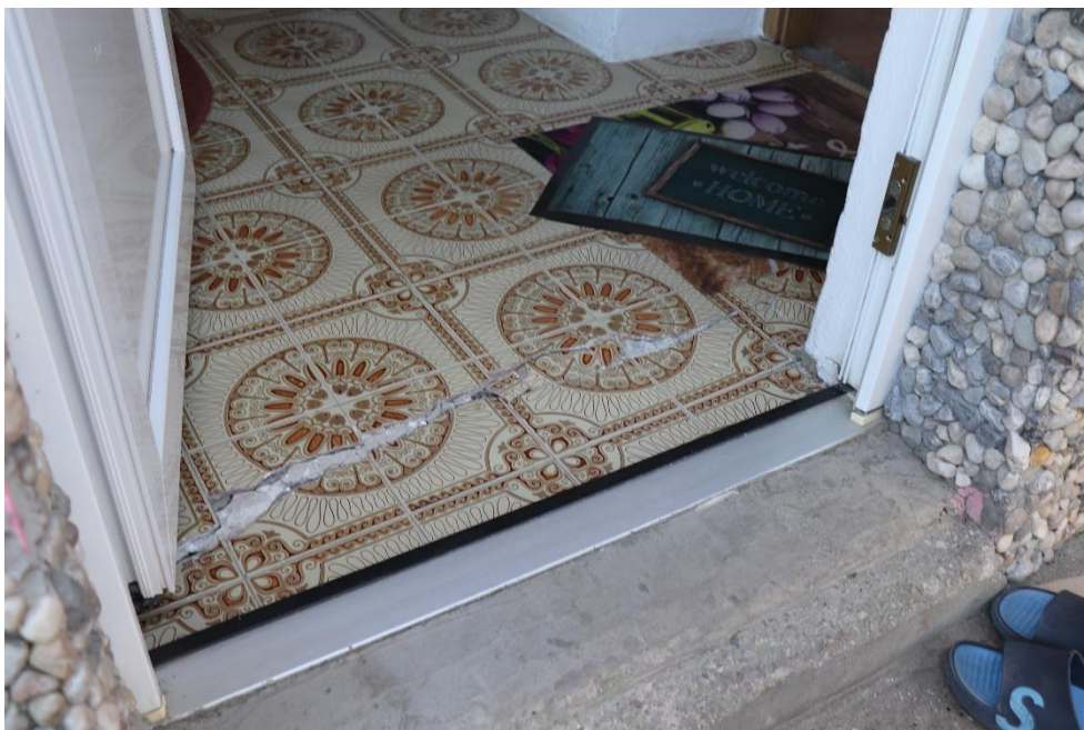
Slika 18: Razpoke v AB plošči na objektu Sava 4, Litija. (foto: Gosar, 5.3.2025)
