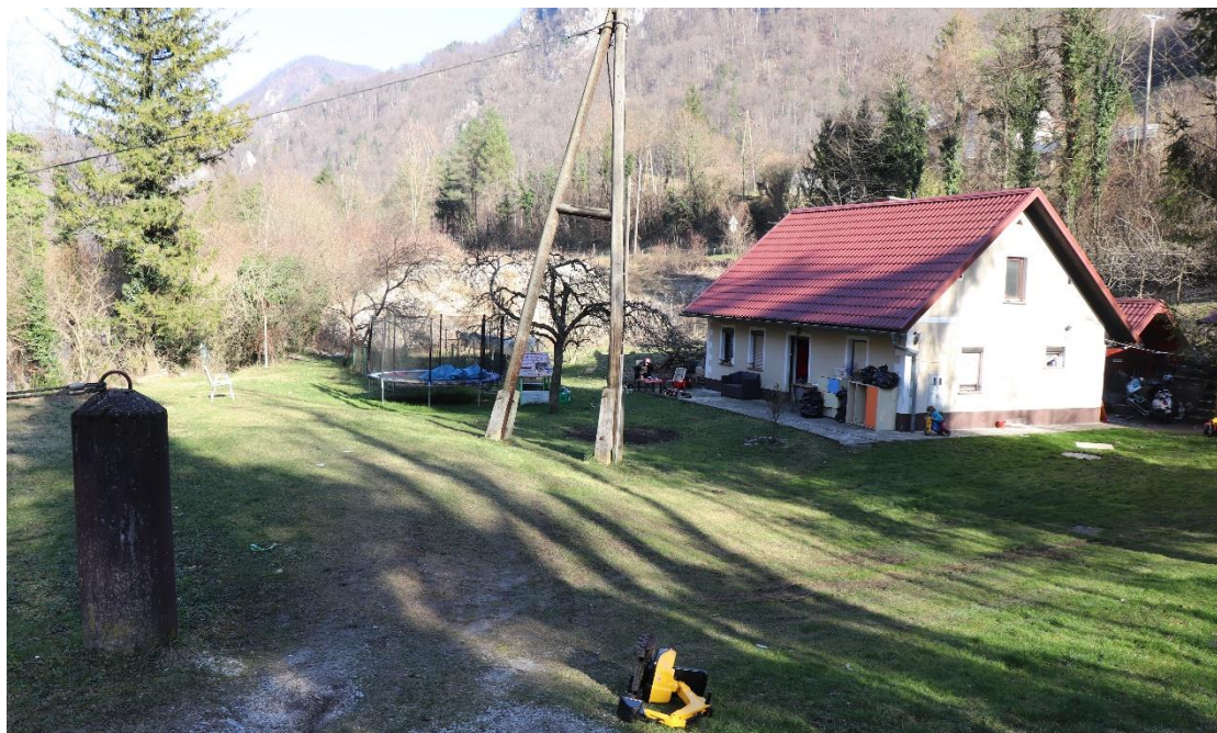
Slika 4: Prikaz obravnavanega objekta Renke 7, Litija (foto: Gosar, 5.3.2025).
