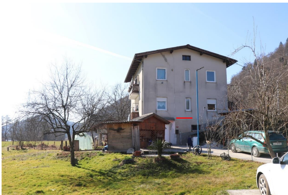
Slika 16: Prikaz obravnavanega objekta Sava 4, Litija z označeno višino poplavnih voda avgusta 2023 (foto: Gosar, 5.3.2025).
