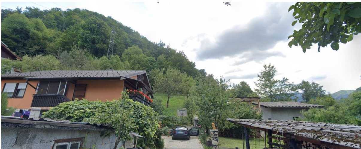
Slika 22: Prikaz obravnavanega objekta Taborniška pot 18 a, Hrastnik. (vir: Google Street View)
