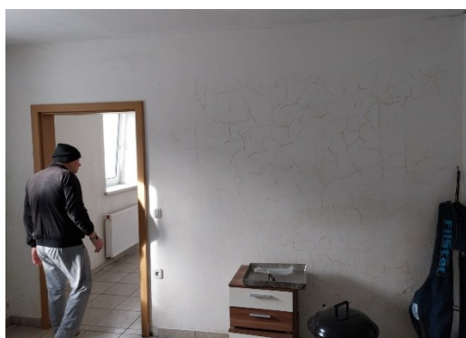
Slika 5: mrežaste razpoke ometa v kletni etaži
