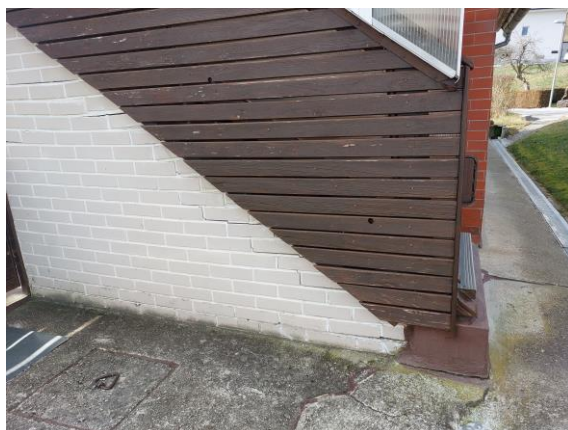
Fotografija 2: Razpokan kmetijski objekt na vzhodni strani stanovanjskega objekta (12.1.2024).
