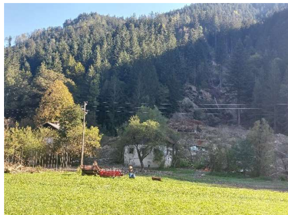
Fotografija 2: Pogled na poškodovani stanovanjski in kmetijski objekt (11.10.2023)
