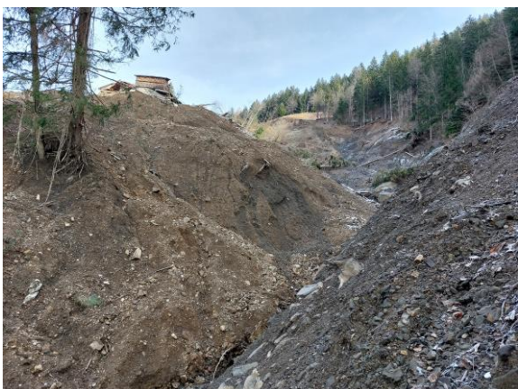
Fotografija 3: Osrednji del zemeljskega plazu – grapa po kateri se pretaka voda (8.12.2023)
