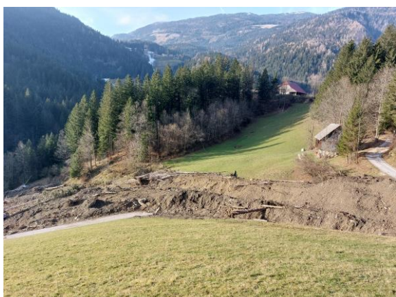
Fotografija 5: Pogled na lokacijo objekta Konjski vrh 41 (8.12.2023)
