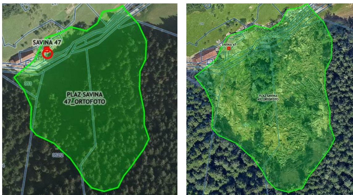
Slika 3 – prikaz območja plazu Zgornji Trbiž – Štepihar na ortofoto posnetku pred sprožitvijo in po sprožitvi plazu. Na desni viden uničen stanovanjski objekt Savina 47.
