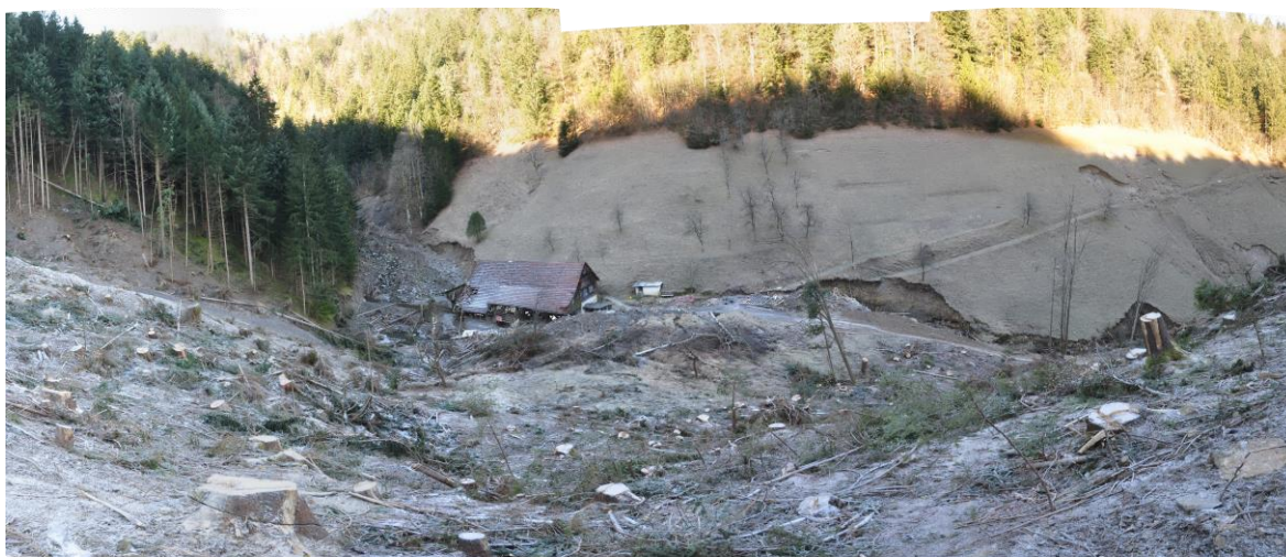
Fotografija 3: spodnji del plazu – noga in peta plazu sta zasuli strugo potoka Trbiški graben in podrla stanovanjski objekt Savina 47.
