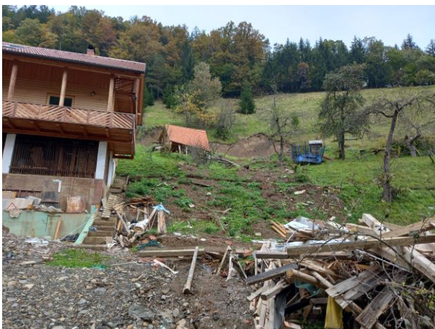
Fotografija 3: poškodovan objekt Savina 44 (dolvodno) zaradi usada nad objektom Savina 43 in erozije vode.
