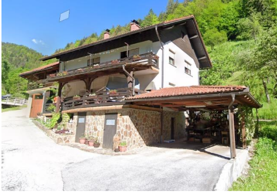
Fotografija 1: Pogled na lokacijo, kjer je stal objekt ter plaz, ki se je sprožil v ozadju
