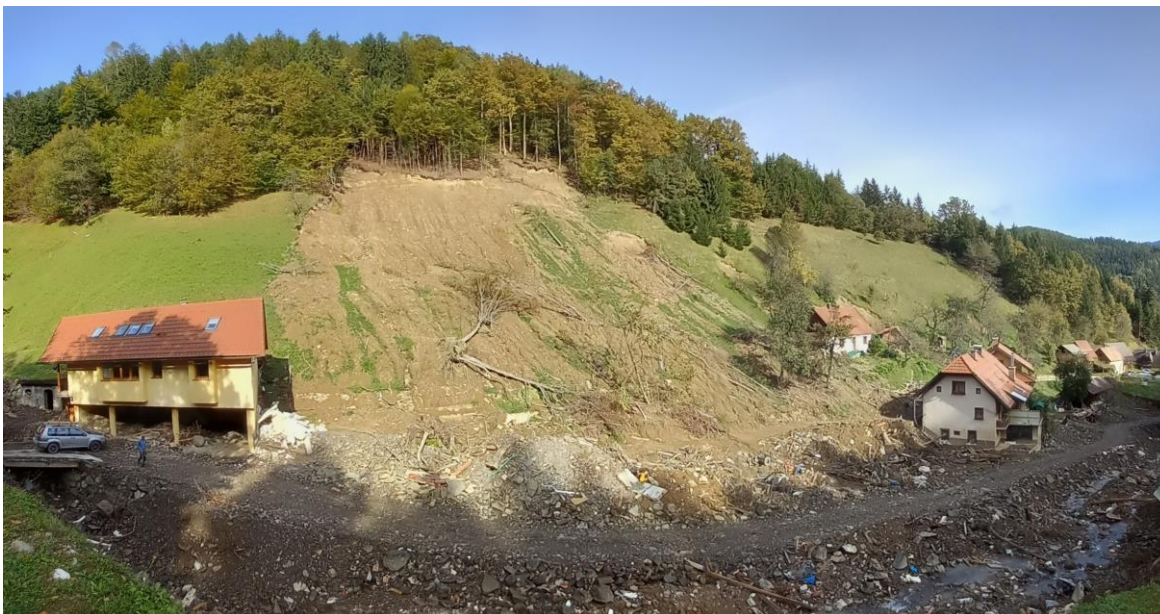
Fotografija 1: Pogled na usad iz zgornjega dela travnatega pobočja, ki je uničil objekte Savina 45 in Savina 45A ter poškodoval objekte Savina 44.
