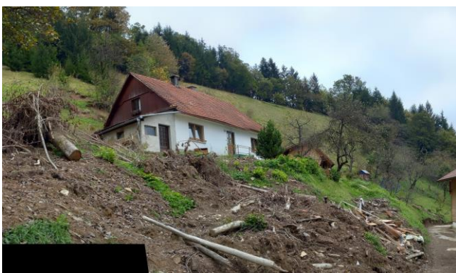
Fotografija 7: Poškodovan objekt Savina 43. Desno porušena drvarnica.
