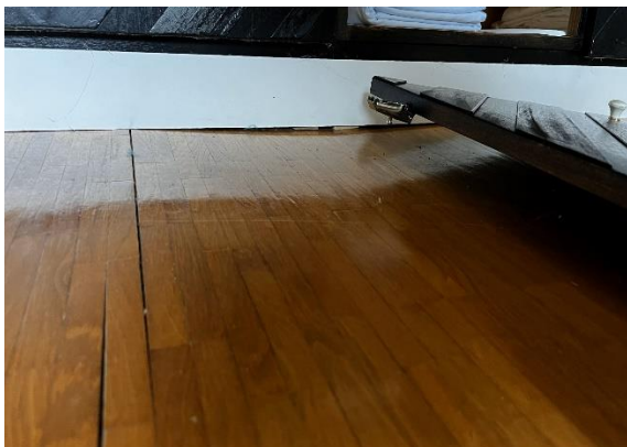
Posedek tal v dnevni sobi na podstrešju pritličju
