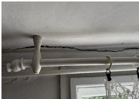
Izrazita razpoka na stiku strop - stena v
