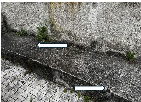
Izrazite prečne razpoke
