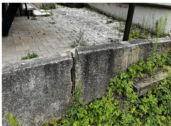
Posedek opornega zidu ob objektu
