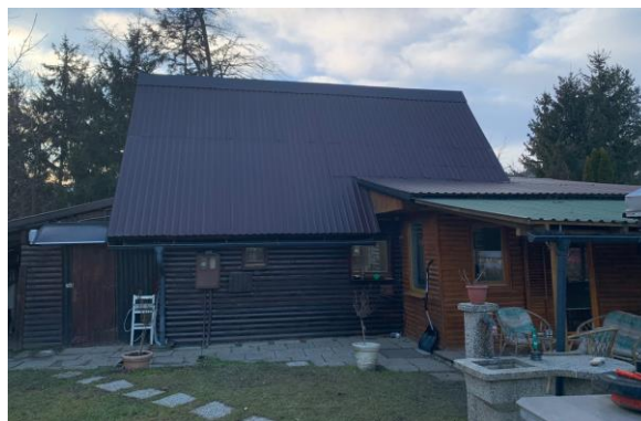
Slika 36: Objekt Pod gonjani 160 (vir: VGB Maribor)
