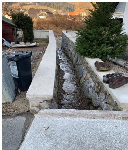
Slika 33: Izlivni odsek Gutmanovega potoka
