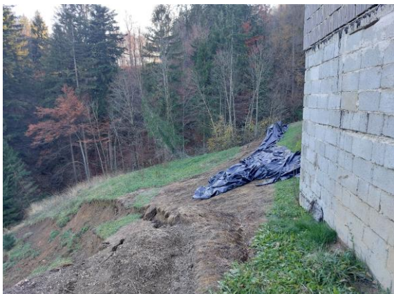
Fotografija 1: Pogled na odlomni rob pod objektom Poljane 26, razpoke vidne tudi na travniku desno od objekta (22.11.2023)
