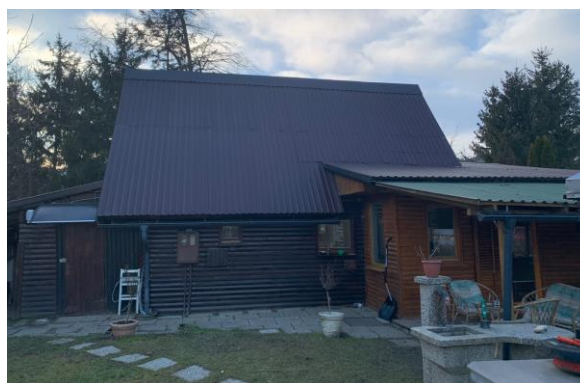
Slika 35: Objekt Pod gonjami 160 (vir: VGB Maribor)
