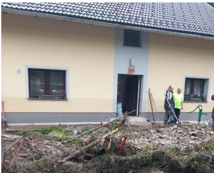
Slika 5: Vhod v objekt Kropa 5 po poplavi (vir: ga. Čeplak)
