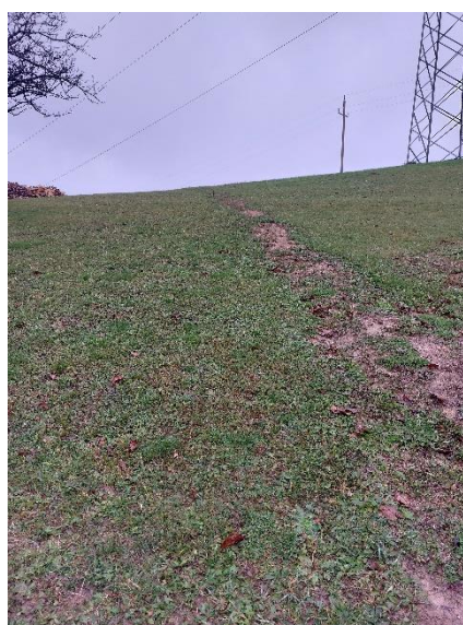
Fotografija 6: Vzdolžna razpoka pod daljnovidnim stebrom (21.11.2023)
