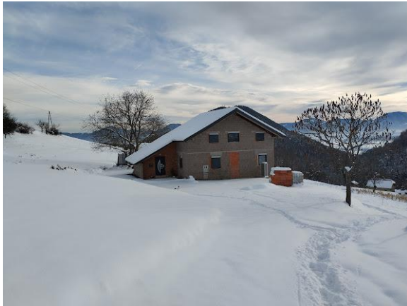
Fotografija 3: Pogled iz smeri S .. stavba 276 (hiša)
