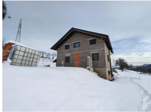
Fotografija 4: Pogled iz smeri SZ .. stavba 276 (hiša)
