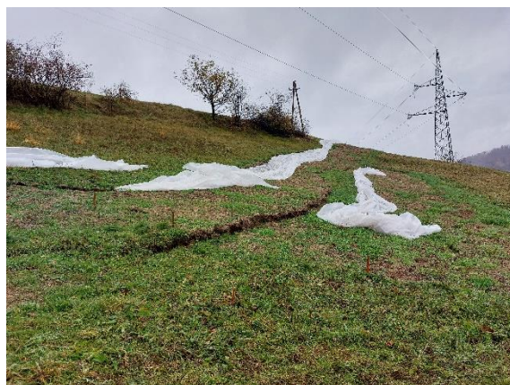
Fotografija 4: Vzdolžna razpoka sega vse do daljnovidnega električnega stebra (21.11.2023)
