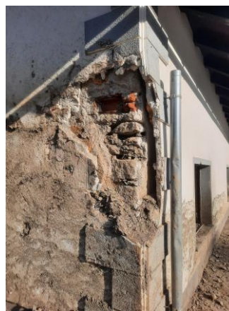
Slika 3 in 4: Stanovanjski objekt – Strmec 5 stanje po čiščenju naplavin drobirskega toka (25.10.2023)
