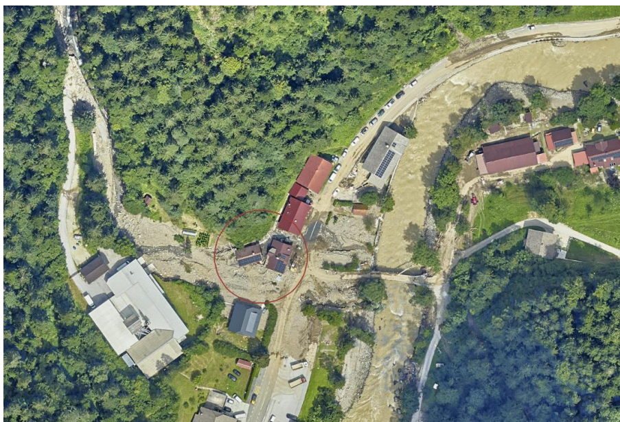
Slika 1: Pogled (DOF) na območje stanovanjskega objekta Strmec 5, po ujmi avgusta 2023
