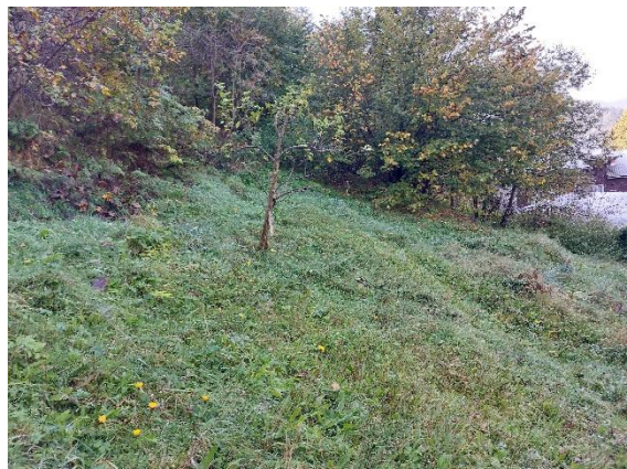
Fotografija 2: Pogled na zaledje stanovanjskega objekta, kjer morfologija terena in nagnjenost dreves nakazuje na aktivnost plazjenja (12.10.2023)
