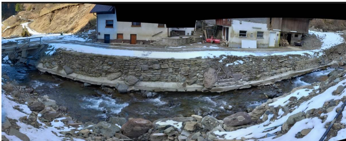
Slika 5 – prikaz erozijskih poškodb ob objektu Planina 21. Levo od hiše je erozijski jarek že zasut.
