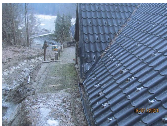
Fotografija 4: Pogled na stanovanjsko - gospodarski objekt (sever)
