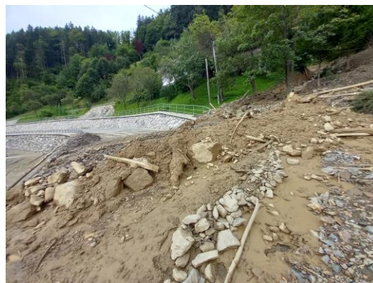
Slika 2: Objekti Lom 4 in prikaz materiala drobirskih tokov, ki so zasuli in zaprli cesto.
