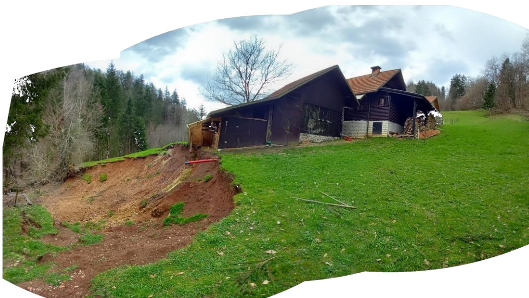
Slika 3: Plaz pod objektom Laniše 15 ogroža objekte.
