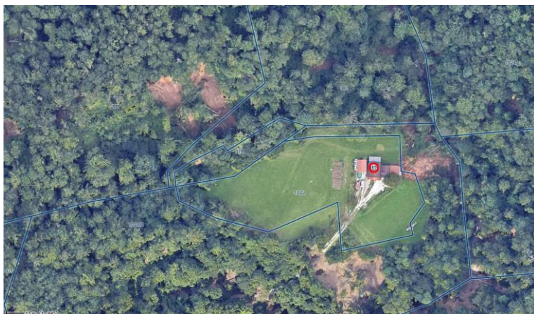
Slika 1: Prikaz objekta Laniše 15 (Kamnik) na ortofoto posnetku iz avgusta 2023. Vidni so številni plazovi in usadi, ki ogrožajo objekt, uničili so tudi dostopne poti do lokacije.
