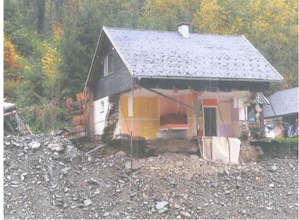
Fotografija 2: pogled na poškodovan objekt
