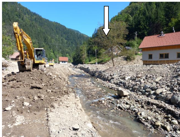
Fotografija 2: Čiščenje struge potoka Krumpah (11.9.2023). S puščico označen objekt Ter 79, desno Ter 76.
