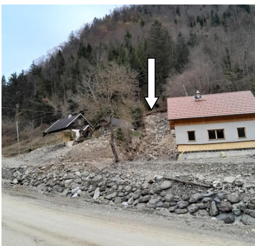
Fotografija 3: Nanosi grušča zalednega neimenovanega potoka – ogrožanje objektov Ter 79 in Ter 76.
