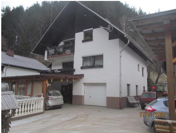
Fotografija 1: Pogled na stanovanjski objekt (jug in vzhod)
