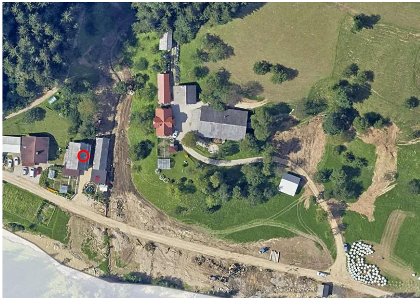
Slika 1: Pogled (DOF) na območje stanovanjskega objekta Spodnji Razbo 59, po ujmi avgusta 2023
