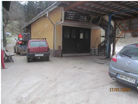
Fotografija 3: Pogled na gospodarski objekt (jug in vzhod)
