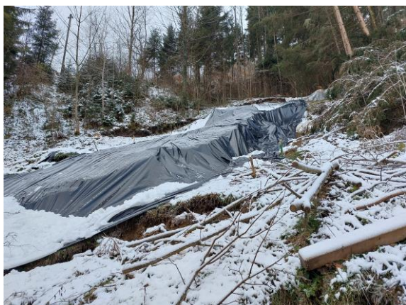
Fotografija 3: Pokriti aktivni plaz na JV delu stanovanjskega objekta. (6.12.2023).
