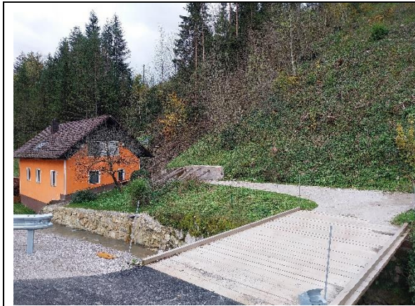
Fotografija 1: Pogled na stanovanjski objekt (sever in zahod) in plazovito brežino
