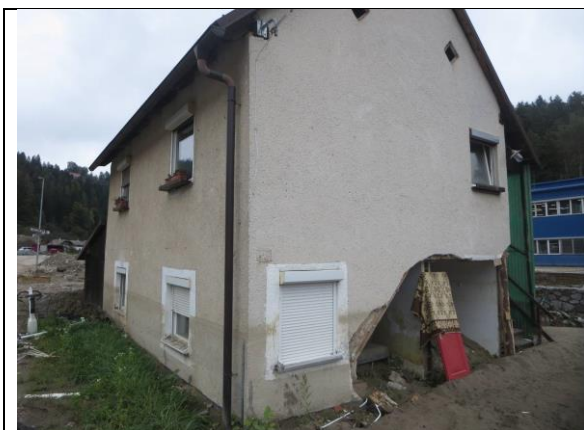
Zahodna in južna fasada
