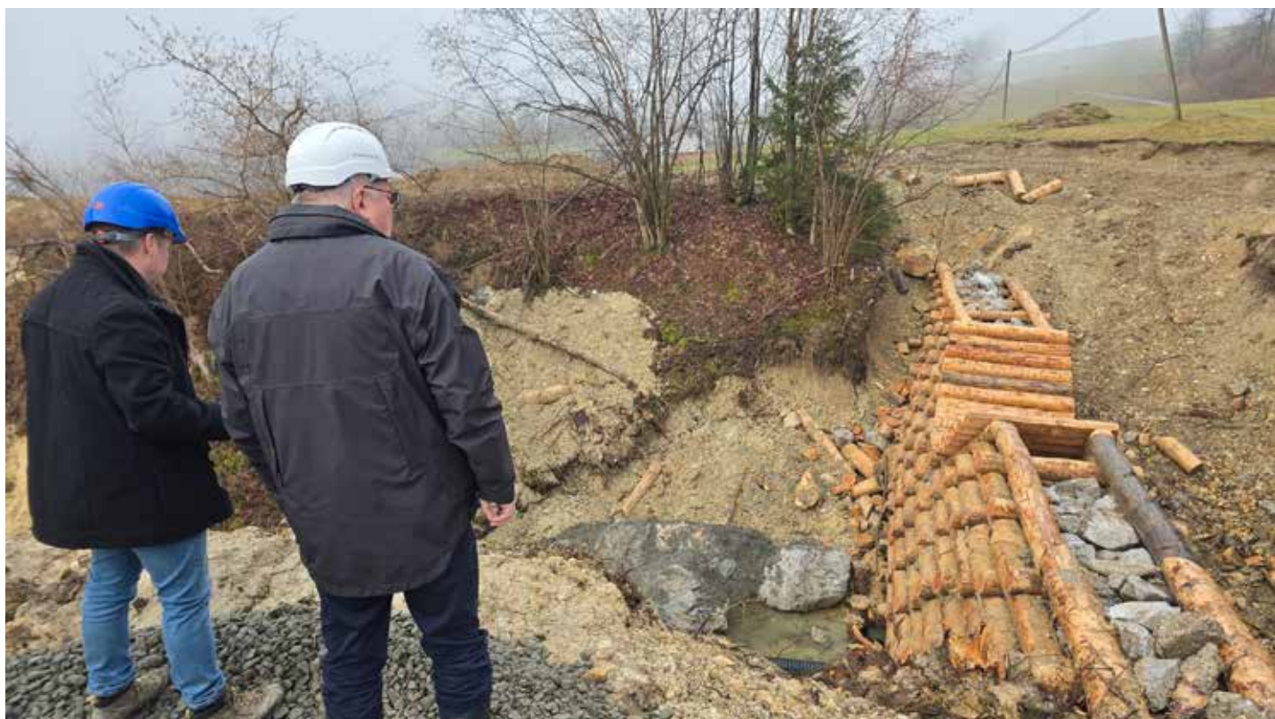
Minister Jože Novak na ogledu sanacije plazu Koroška Bela v občini Jesenice. Foto: arhiv MNVP
