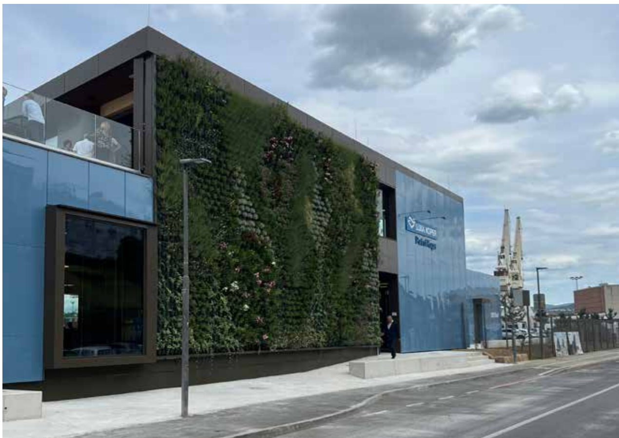
Potniški terminal Koper. Foto: arhiv MZI
