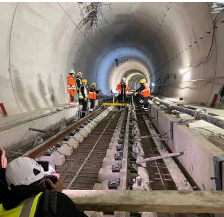
Gradnja 2. tira Divača-Koper. Foto: 2TDK
