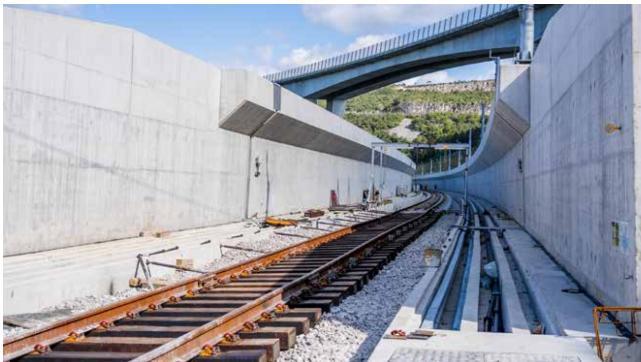
Gradnja 2. tira Divača-Koper. Foto: 2TDK
