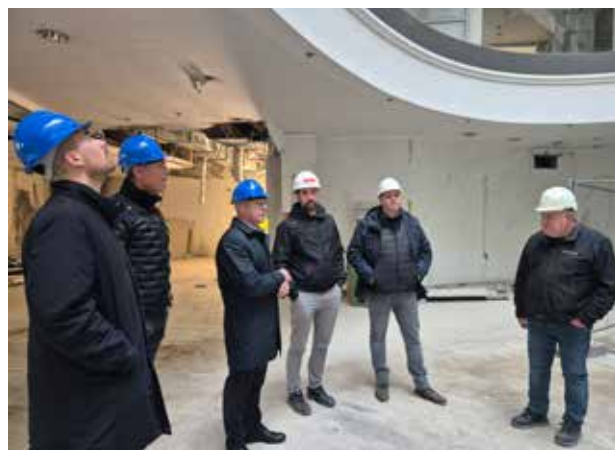
Ogled prenove stavbe upravne enote v Mariboru med vladnim regijskim obiskom. Foto: arhiv MJU
