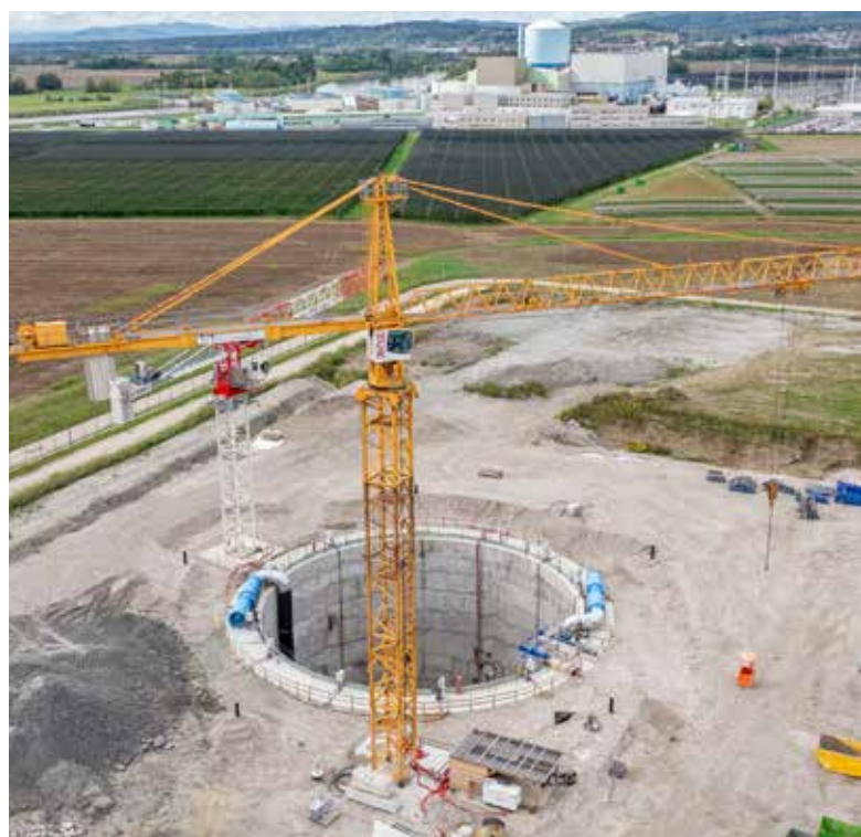
Odlagališče NSRAO v gradnji. Foto: arhiv MNVP
