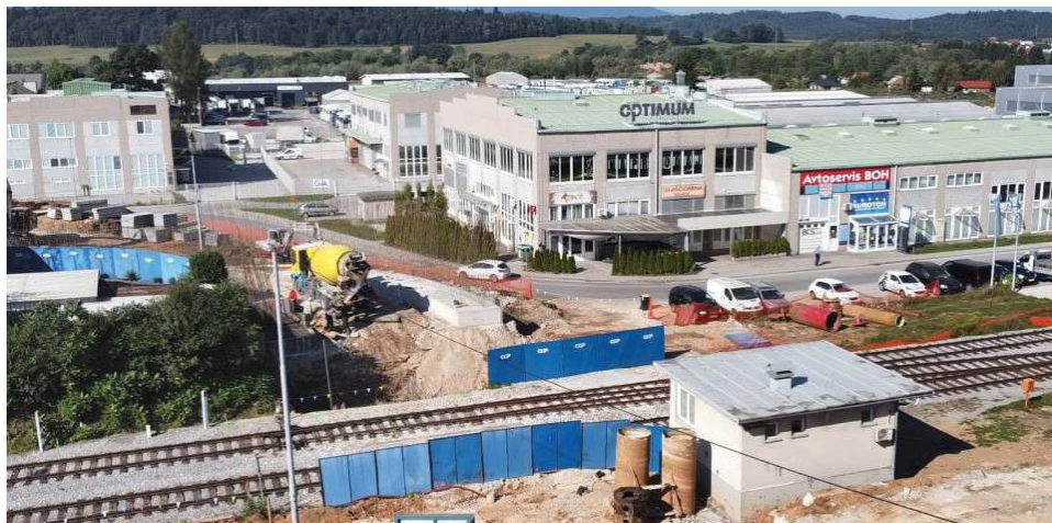
Nadgradnja železniške postaje Grosuplje in gradnja novega nadvoza Motvoz.
