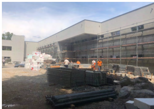
Novogradnja Oddelka za invalidno mladino in rehabilitacijo - ZIM Stara Gora med gradnjo. (foto: ZIM Stara gora)
