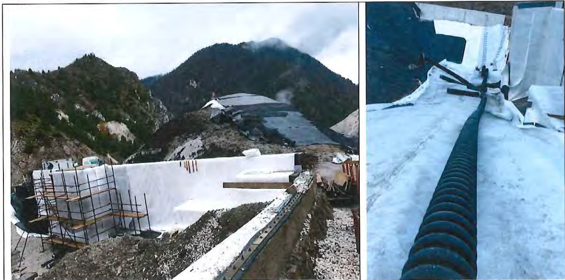
Slika 3: Preplastitev vmesne pregrade (levo) in zatesnitev prebojev in položitev dodatne drenaže za izcedne vode (desno).
