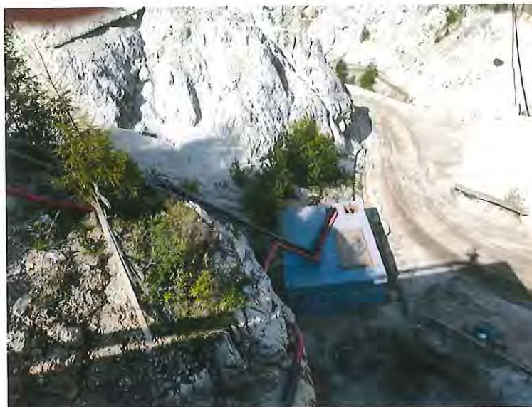
Slika 1: Cevne povezave za združitev in odvodnjo izcednih voda proti zgornjemu zbirnemu bazenu.
