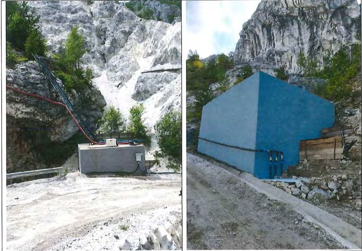
Slika 4: Zgornji (levo) in spodnji bazen izcednih vod (desno).
